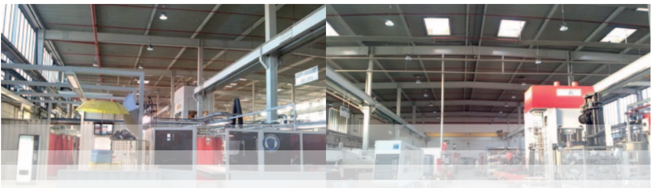
Halle 7: Umgesetzte LED-Hallenbeleuchtung
