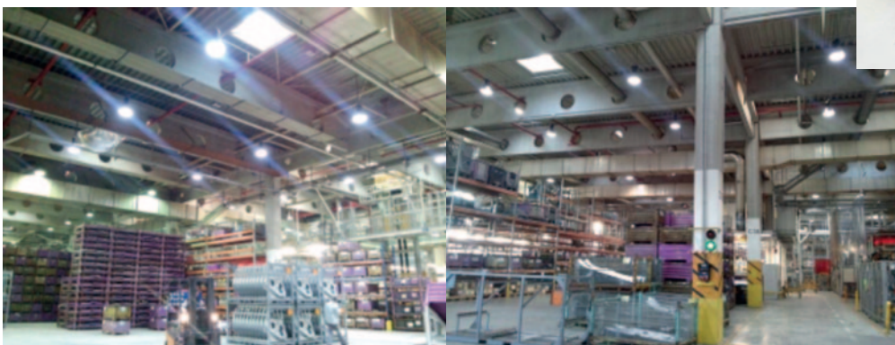
Halle 7: Umgesetzte LED-Hallenbeleuchtung
